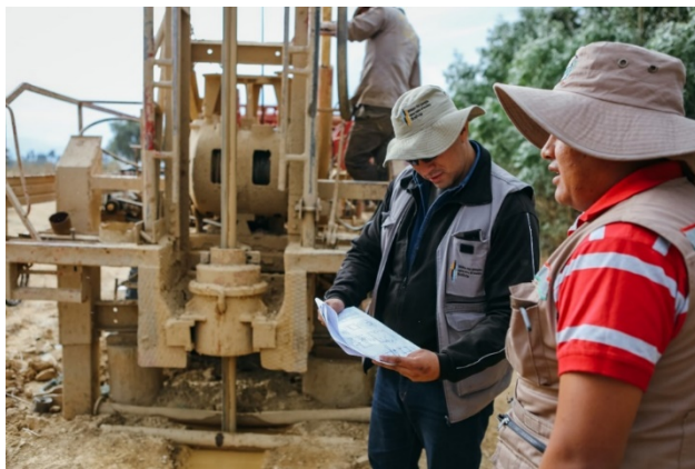
Représentants du District Office EHA discutant des plans de conception durant la construction du premier système d'eau dans la villa impériale de la communauté de la municipalité d'Arbieto en Bolivie (Photo : Water For People)
