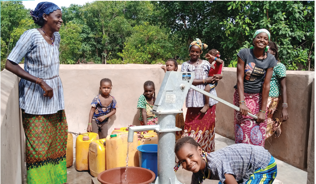
Approvisionnement en eau de communautés au niveau du forage équipé de PMH du quartier Barrage du village de Bodadiougou dans la commune de Banfora -2021. [Photo par Ismail KABORE / CRS]
